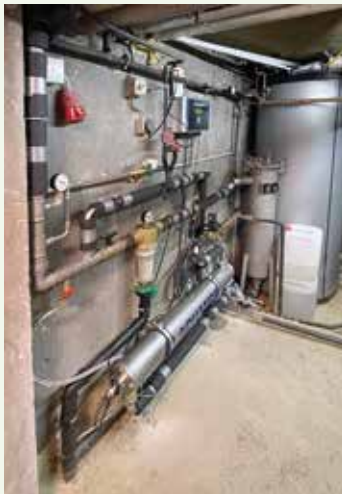
Mit dieser Anlage wird nun das Trinkwasser aufbereitet
