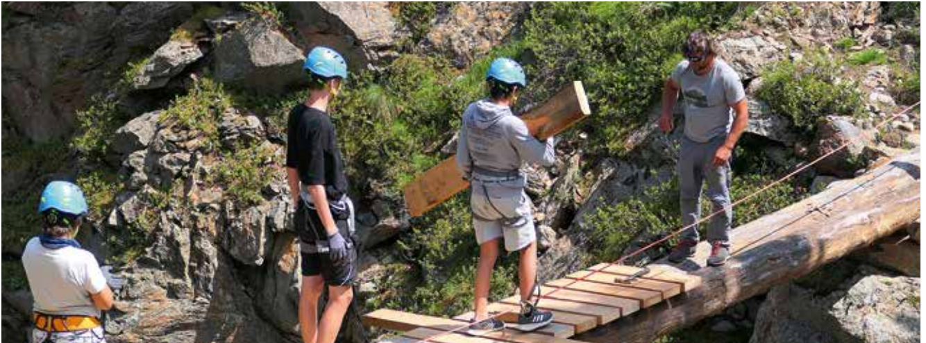
8 KLIMABAUSTELLE IM KAUNERTAL
